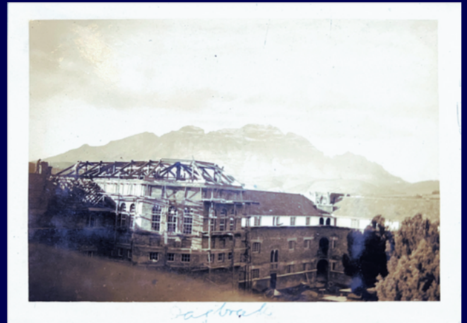
Die konstruksie van die eetsaal in Augustus 1927
